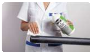
Oberflächen mit geeigneten Reinigungsmitteln säubern.
