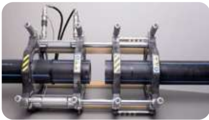
Schweißstücke in der Maschine positionieren.
