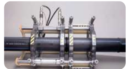
Fase 5: soldadura con elementos en presión.
