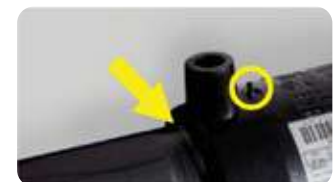
Mit der Schweißung beginnen. Die Kontrollen durchführen (Schweißparameter und Ausrichtung).
